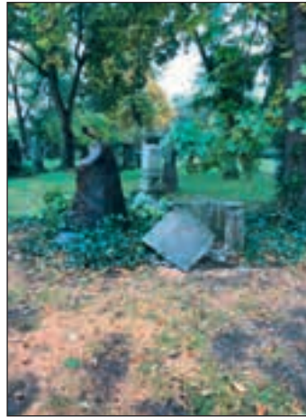
Nach dem Sturmschaden. Foto: GB
