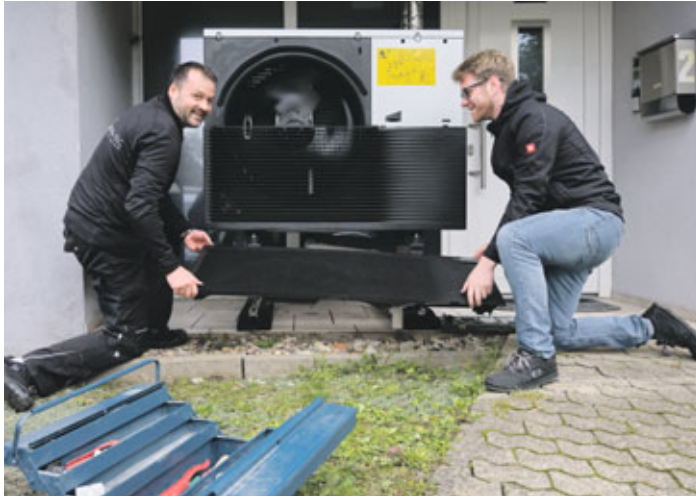
Montage einer Wärmepumpe.
