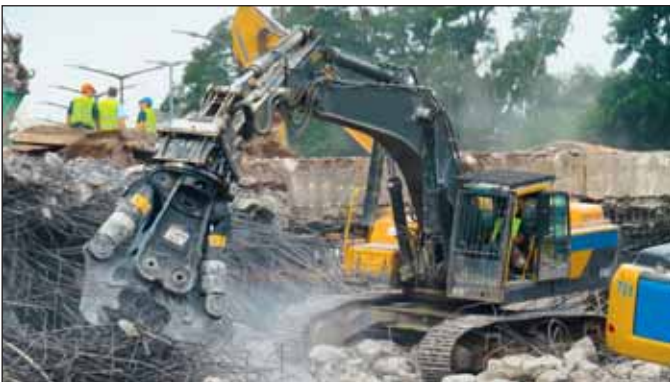
Demontage, Abrissarbeiten und Rückbau, alles in einer Hand.
