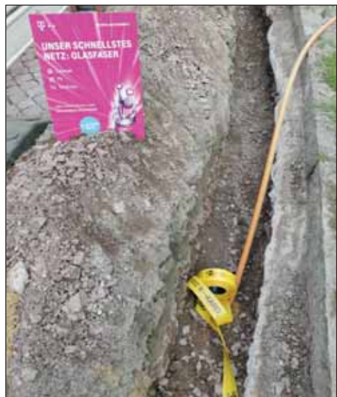
Glasfaser für Braunschweig: Rund 30.500 Haushalte sollen im Jahr 2021 schnelles Internet bekommen.
