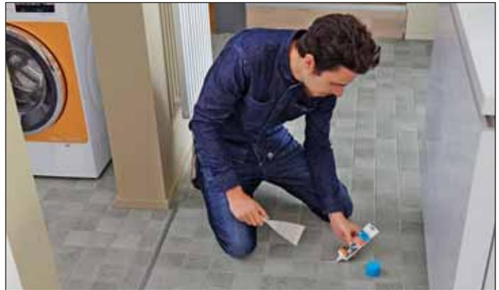
**Kleine Schadstellen, die etwa beim Einzug immer passieren können, lassen sich mit einer Fugenreparatur schnell beheben.**
